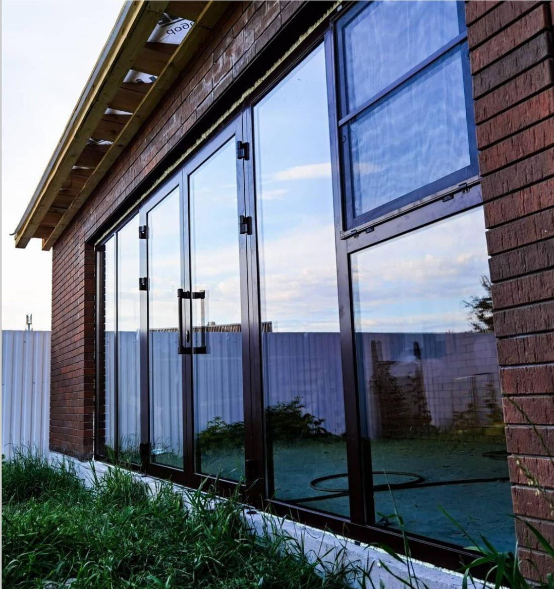
ALT 65 – оконно-дверная серия с терморазрывом, является уникальной комплексной системой и позволяет изготовить окна и входные двери в административных, производственных и жилых зданиях; витражи с большим количеством дверей и окон, типы рамных конструкций с повышенными требованиями к тепло- и звукоизоляции.
