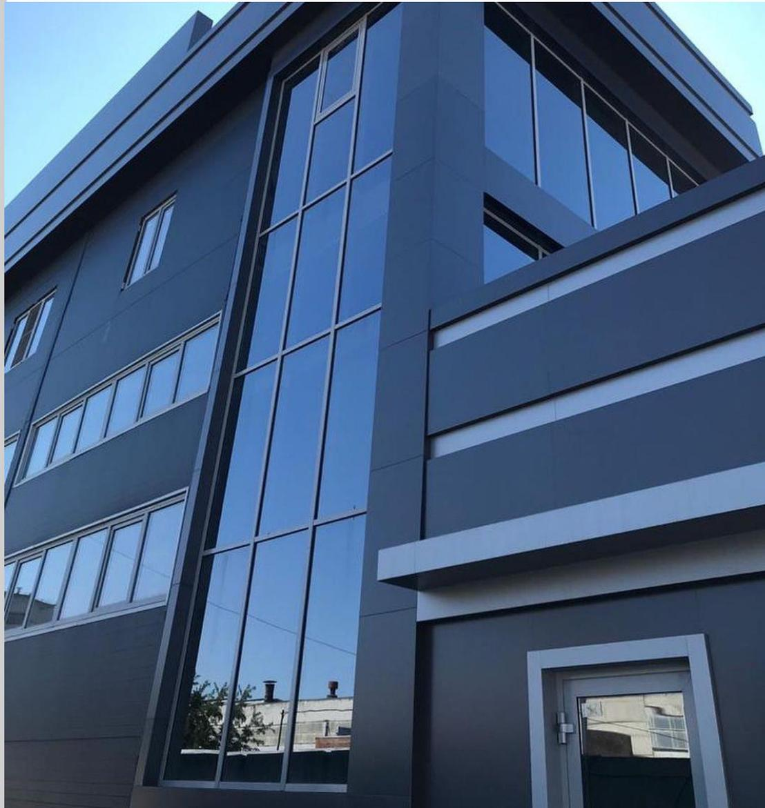
ALT 72 – оконно-дверная серия с терморазрывом, является уникальной комплексной системой и позволяет изготовить окна и входные двери в административных, производственных и жилых зданиях; витражи с большим количеством дверей и окон, типы рамных конструкций с повышенными требованиями к тепло- и звукоизоляции.
