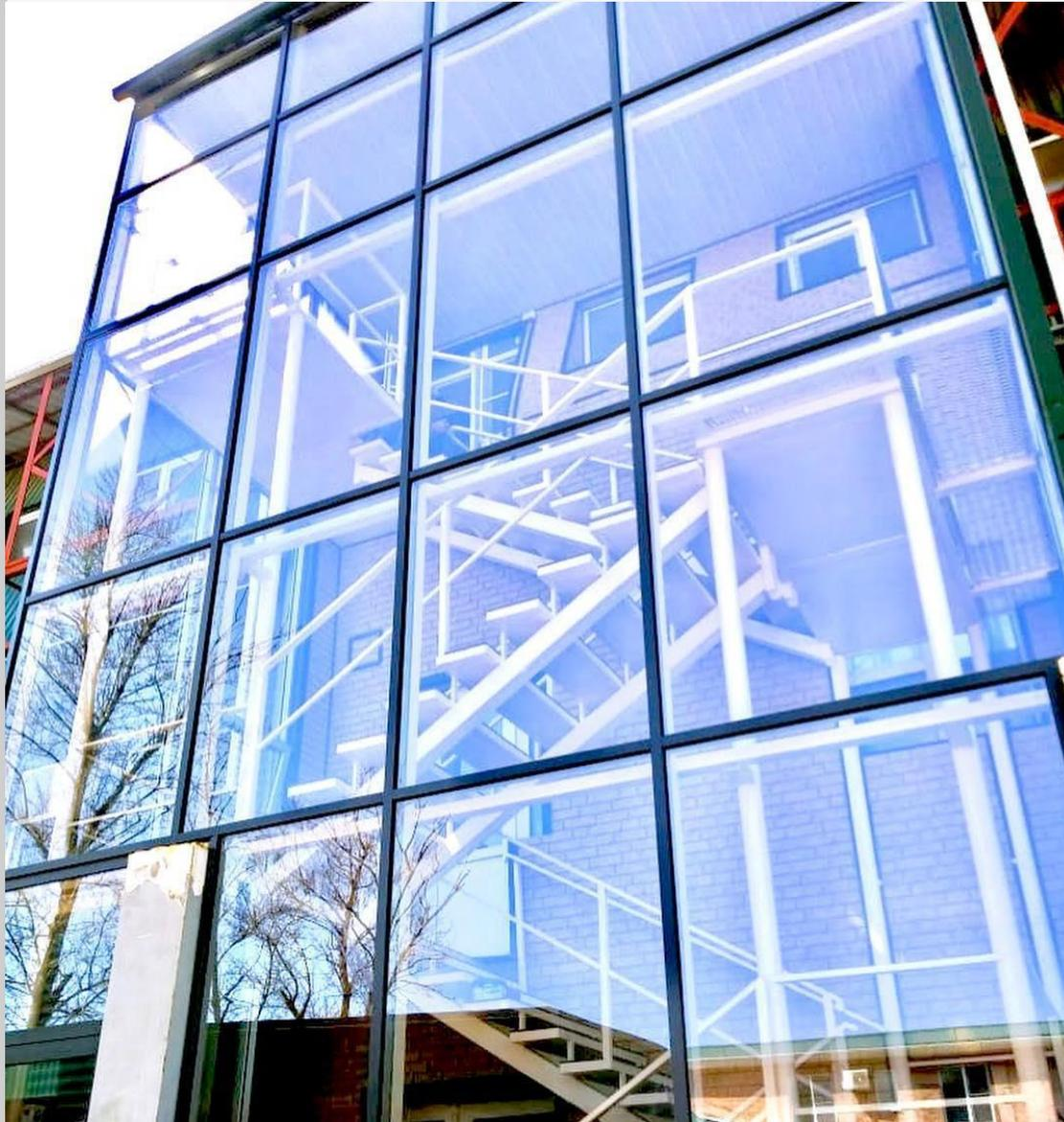
ALF 50 - фасадная серия, применяется как для вертикальных конструкций, так и для наклонных, а также для изготовления наклонных светопрозрачных кровель, фонарей, зимних садов и других пространственных конструкций. Также её можно применять в качестве внутренних перегородок.
