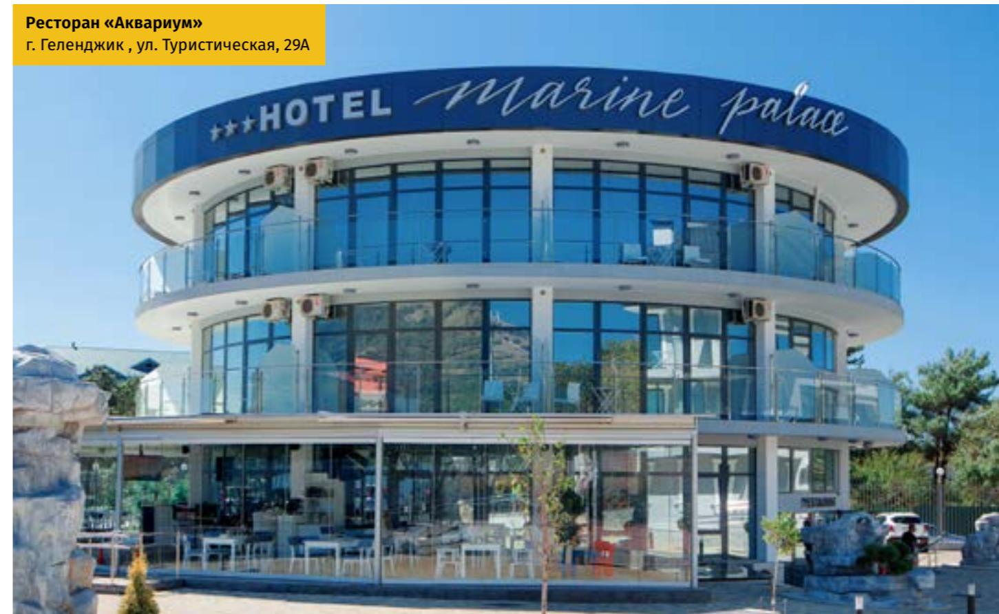
AL 45 – это оконно-дверная серия без терморазрыва, которая предназначена для организации светопрозрачных внешних и внутренних перегородок. Внешние холодные перегородки используются для остекления лоджий или организации неотапливаемых тамбуров.
